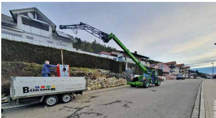
Der firmeneigene Teleskoplader erleichtert den Mitarbeitern der Firma Bürsner die Anlieferung des neuen Pelletkessels.
